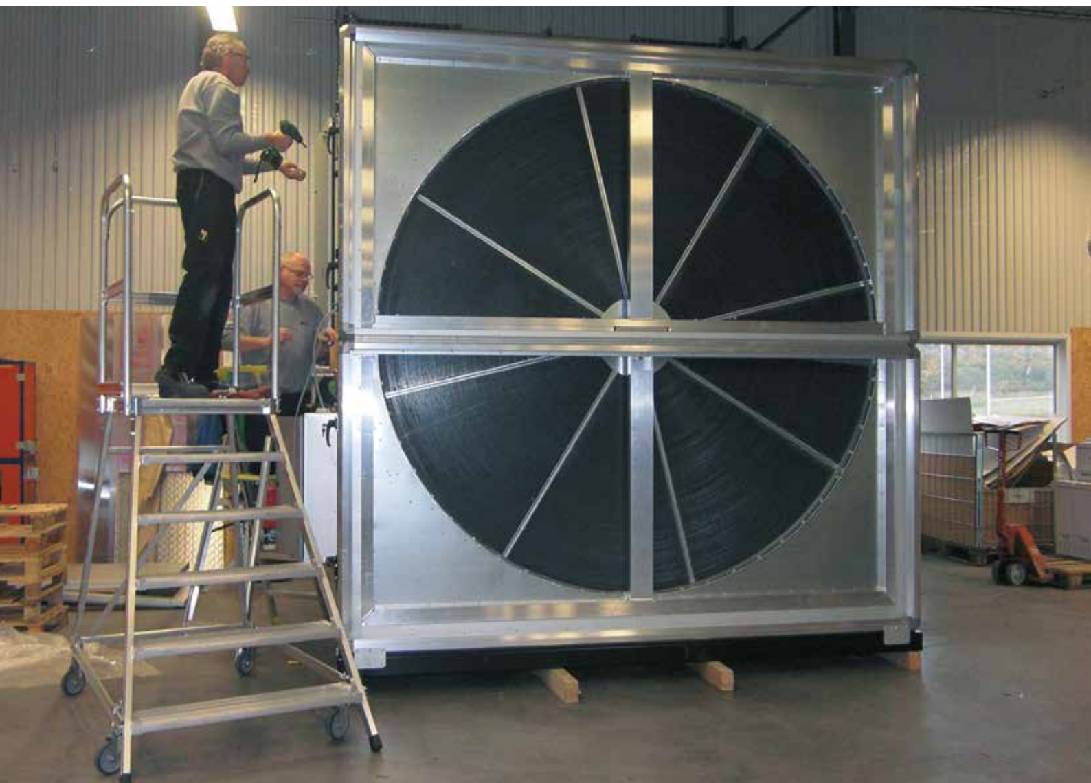
Slutmontering av värmeåtervinningsaggregat LTS Excellent storlek 11
